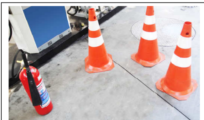
fig 2. Sinalizar, isolar com cones e posicionar um extintor de incêndio, além de certificar-se de que não nenhuma pessoa fumando por perto, são procedimentos prioritários para a execução desta tarefa.
