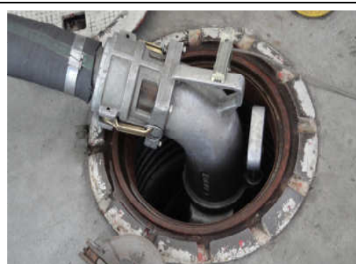
fig 3.2. Antes de autorizar o motorista do CT a iniciar a descarga, certificar-se de que a) O mangote do CT está conectado corretamente na linha de descarga.
