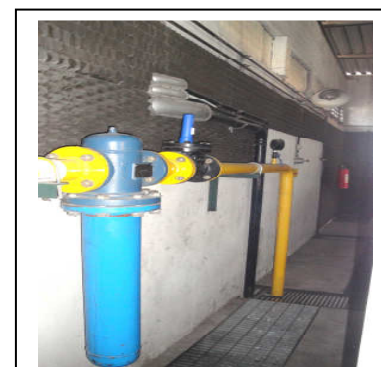
fig 4. Fazer verificação periódica nas válvulas que dão acesso ao ponto baixo dos filtros de linha.
