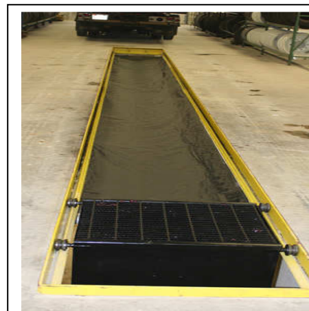
fig 2. Quando não estiver sendo utilizada, a valeta deve ser coberta por madeira, grades ou telas especiais em toda a sua extensão.
